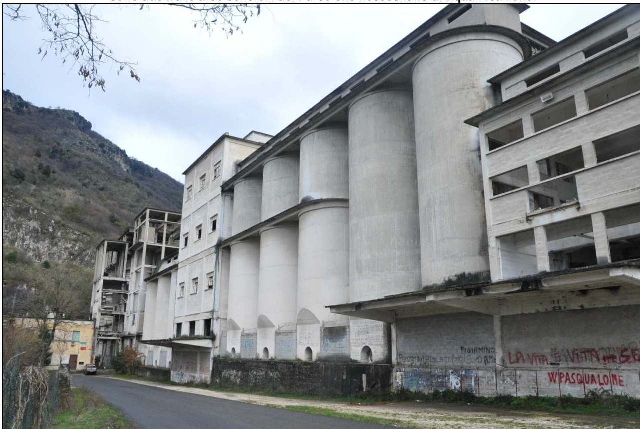
Figura 40 - L'antico cementificio di Marcellina e l'area di Monte Gennaro, con la funivia, l'albergo e le antenne sono due fra le aree sensibili del Parco che necessitano di riqualificazione.
