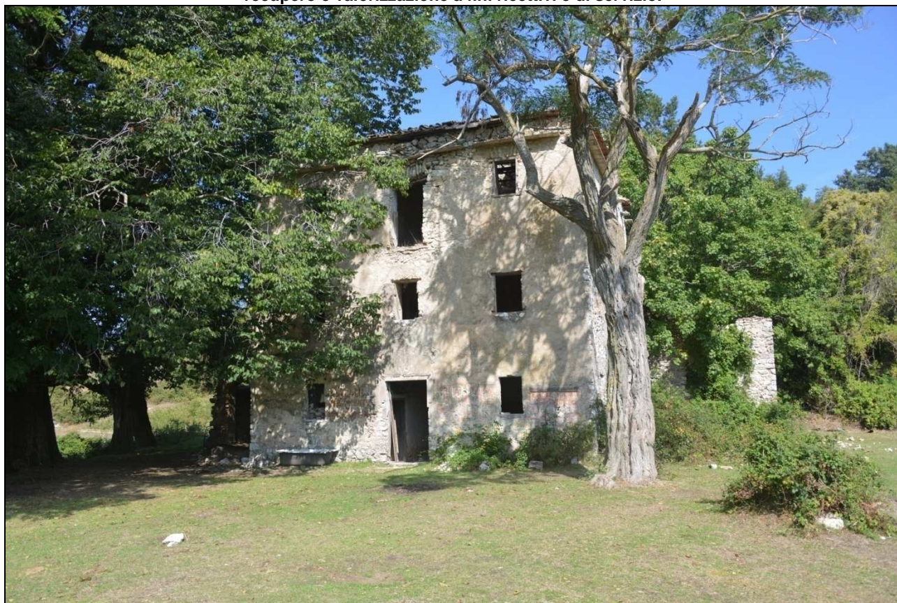
Figura 36 - I casali di Casa di Porco e Palombara sono un esempio del patrimonio rurale del Parco suscettibile di recupero e valorizzazione a fini ricettivi e di servizio.
